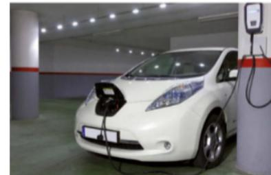
Figura 4.27. Equipo de recarga de vehículo eléctrico.
