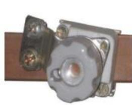
Figura 7.10. Detalle de conexión de base portafusibles Diazed sobre pletina en un embarrado de centralización de contadores.
