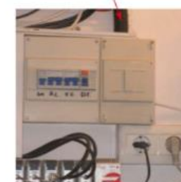
Figura 8.23. Detalle de alimentación de servicios de telecomunicaciones.
