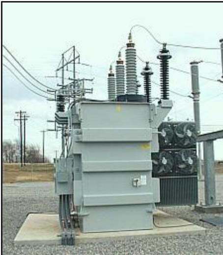
Para el caso de los transformadores, cada devanado forma un electrodo y existe una combinación de conexiones para ir probando los diferentes aislamientos.
